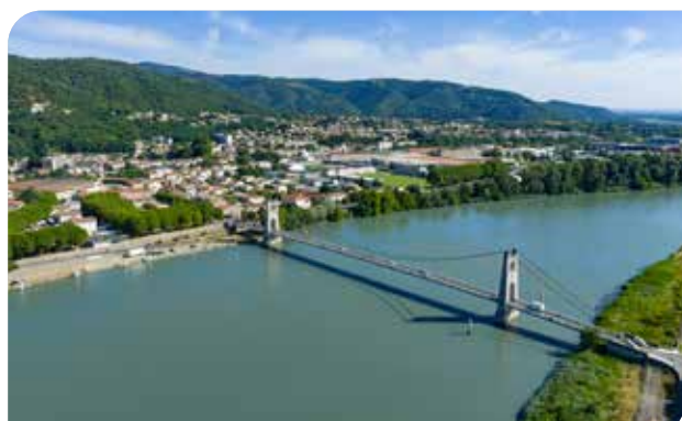
Suspension bridge, La Voulte-sur-Rhône © Ville de la Voulte-sur-Rhône
